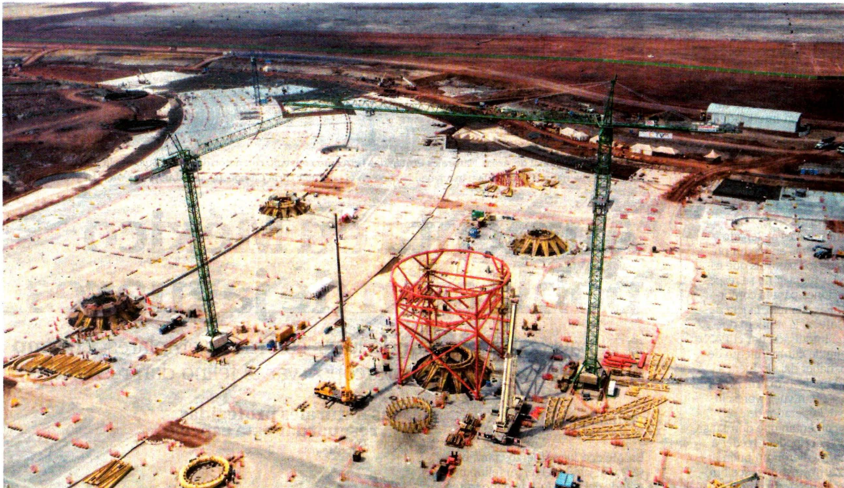
Ya está en marcha el montaje del primer fonil o columna del edificio terminal, con una altura de 40 metros.
