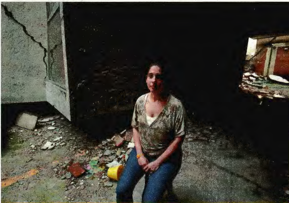
Serena Pérez ha sacado sus pertenencias por la ventana con ayuda de cuerdas, ante la incertidumbre sobre el futuro del edificio, que tiene daños estructurales. "Aunque me digan que se puede restaurar, me da miedo", dice.
