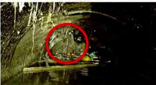
El concreto (círculo) tiene tapado el tubo de drenaje ubicado debajo del Paso Expres.
