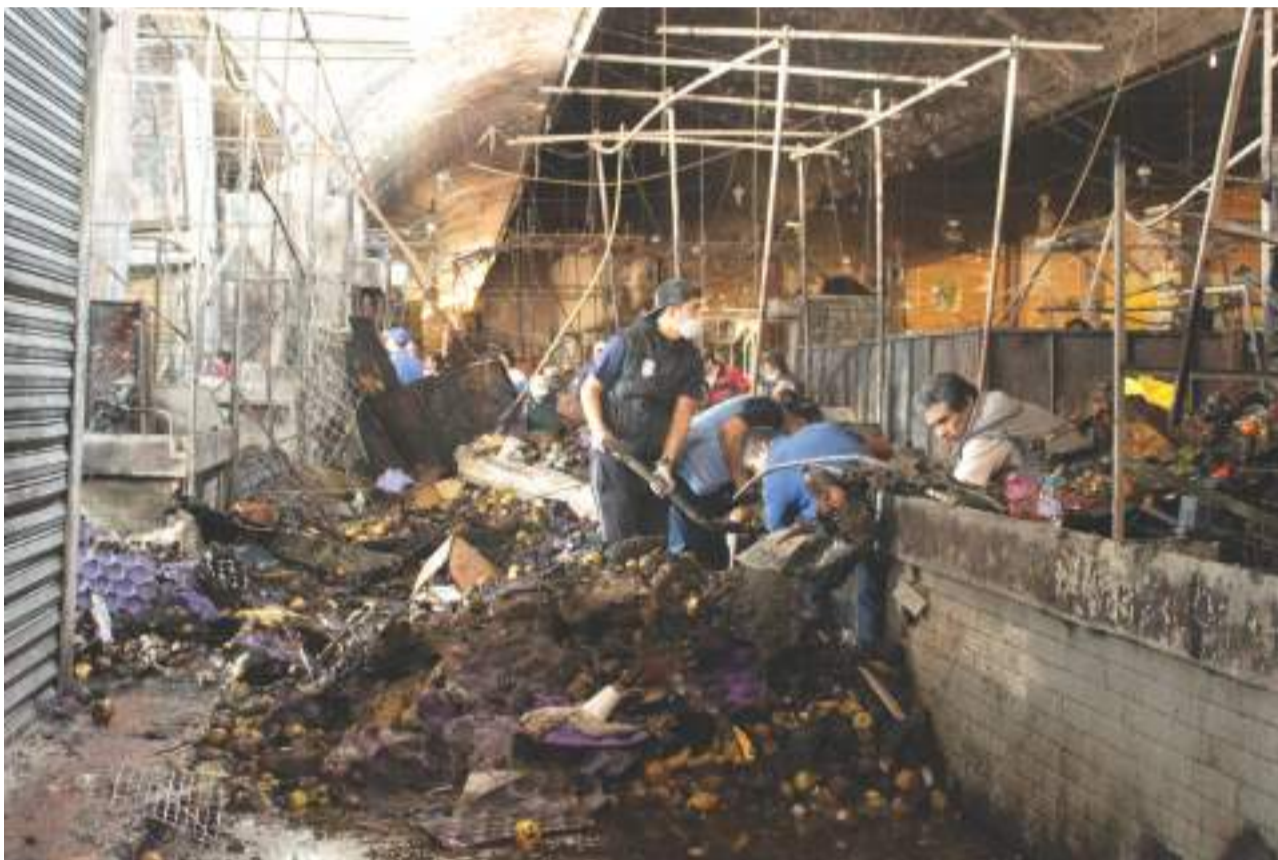
LOCATARIOS, ayer, en los trabajos de remoción de escombros en la nave mayor del mercado de La Merced.
