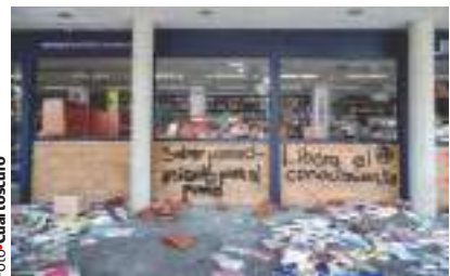
VANDALISMO en la librería González Casanova el 14 de noviembre pasado. Registran hechos en oficio CII/FAAE/CUUI-3C/D/00340/11-2019
