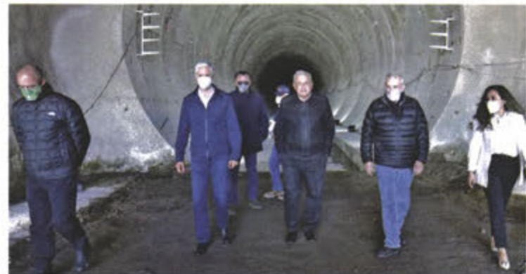
SUPERVISA OBRAS. El presidente revisó ayer avances del tren México-Toluca.
