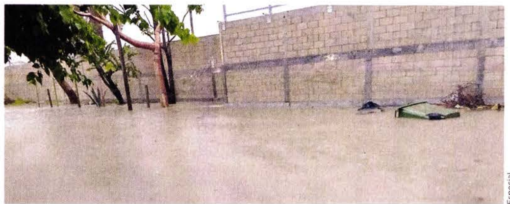
Pobladores aseguran que el terreno aplanado, los nuevos caminos y la barda perimetral de la refinería, han bloqueado el paso del agua de lluvia y su absorción en los manglares.
