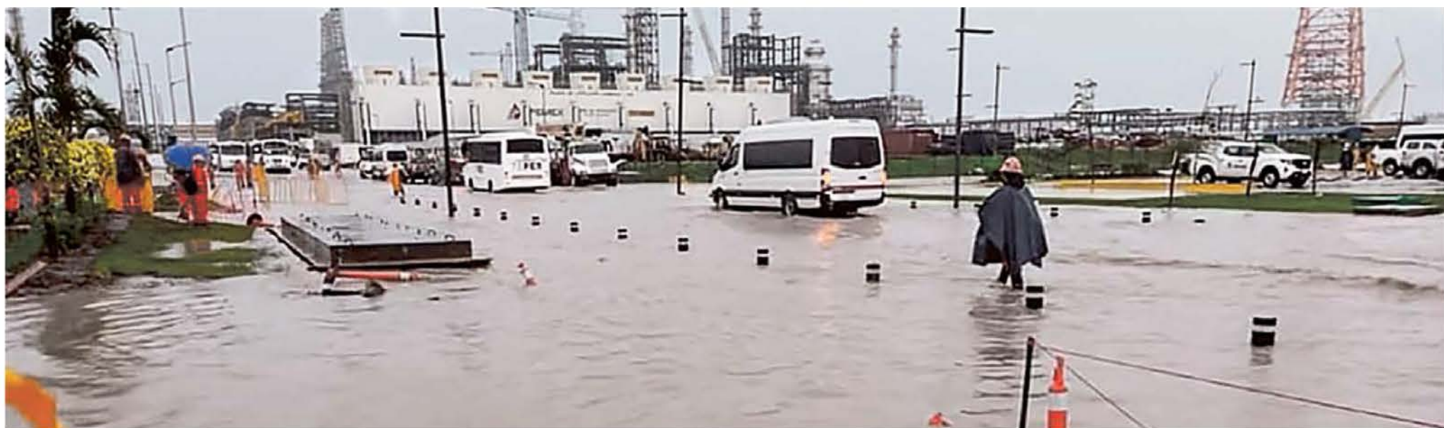
Encharcamientos en Dos Bocas. Las intensas lluvias registradas en Tabasco provocaron inundaciones en la refinería Olmeca, por segundo día consecutivo; una de las obras emblemáticas del Gobierno de Andrés Manuel López Obrador.
