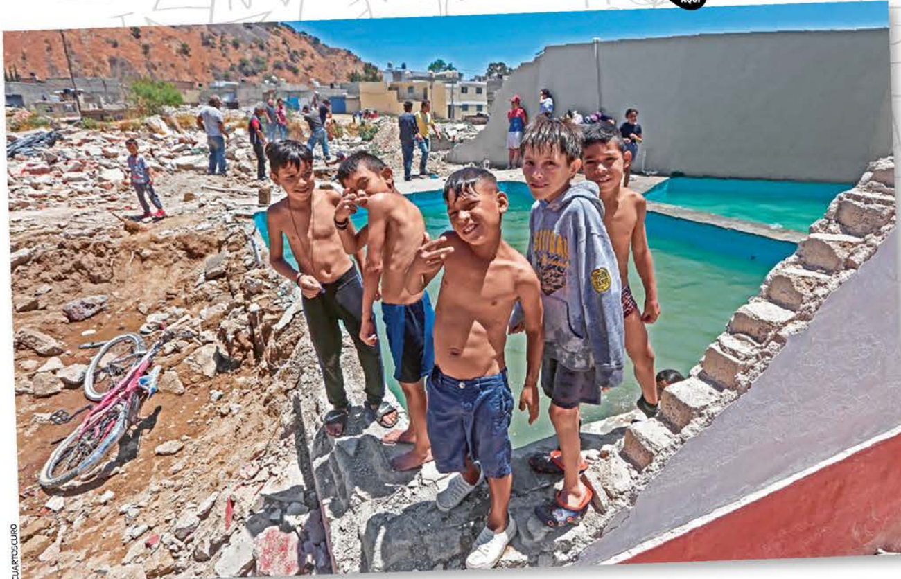
CHAPUZÓN IMPROVISADO. Niños aprovechan que la alberca de una finca derribada quedó al aire libre para refrescarse. Las casas de la colonia Miramar, en Zapopan, Jalisco, fueron demolidas por el riesgo de inundaciones.
