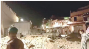
DAÑOS en Marrakech, ayer.
