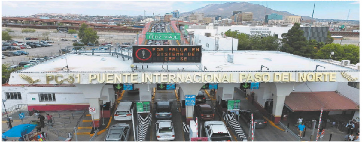
El puente internacional de Ciudad Juárez, Chihuahua, se vio afectado ayer por las fallas de los sistemas operativos de Microsoft en el mundo.
