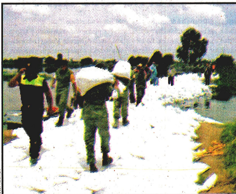
REFUERZAN DIQUE SAN MATEO ATENCO, Méx.- El Ejército colabora con las fuerzas estatales en la reparación de la fisura del río Lerma.
