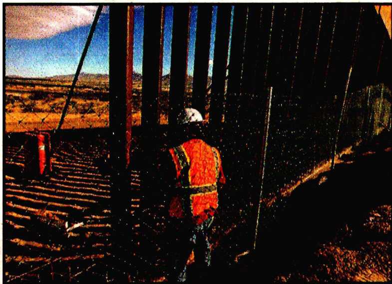
NOGALES, Son.- Mientras, continúa el reforzamiento del muro fronterizo donde ya existe y se está a la espera del nuevo.
