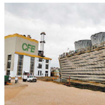
Termoeléctrica. J. CARBALLO
