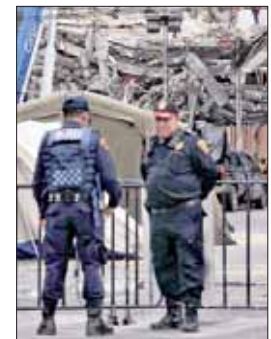
Las losas más pesadas del edificio de Álvaro Obregón 286, colonia Roma, ya fueron retiradas, señalaron encargados del rescate de cuerpos en el inmueble ■ Foto Marco Peláez
