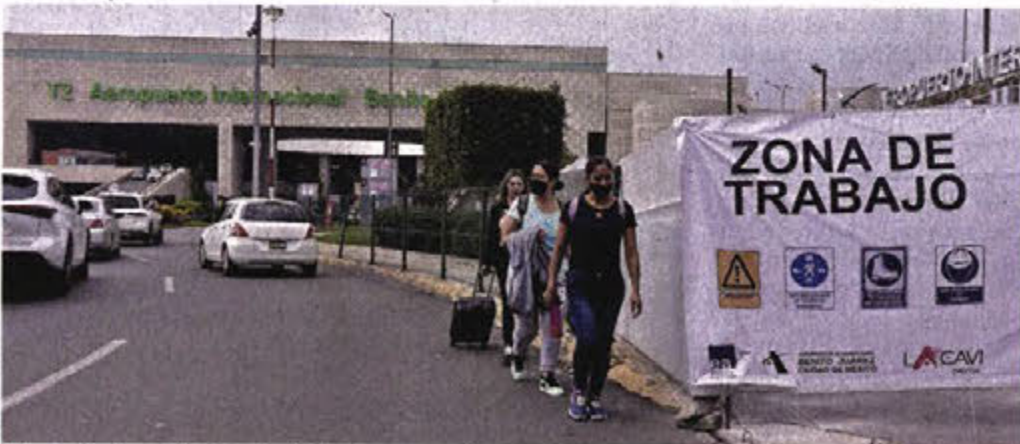
Los trabajos en la Terminal 2 del aeropuerto capitalino ya están en marcha.
