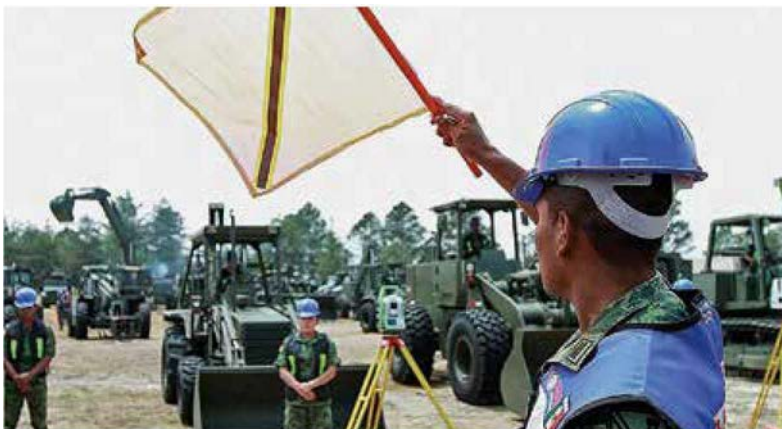
Construcción de obras públicas por parte del Ejército Mexicano.
