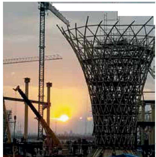
Foto: fonil montado en sitio de obra.
