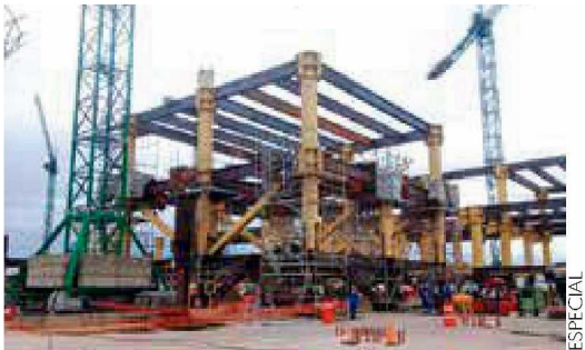
Foto del acero estructural montado en el sitio de construcción del ETP, en Texcoco.
