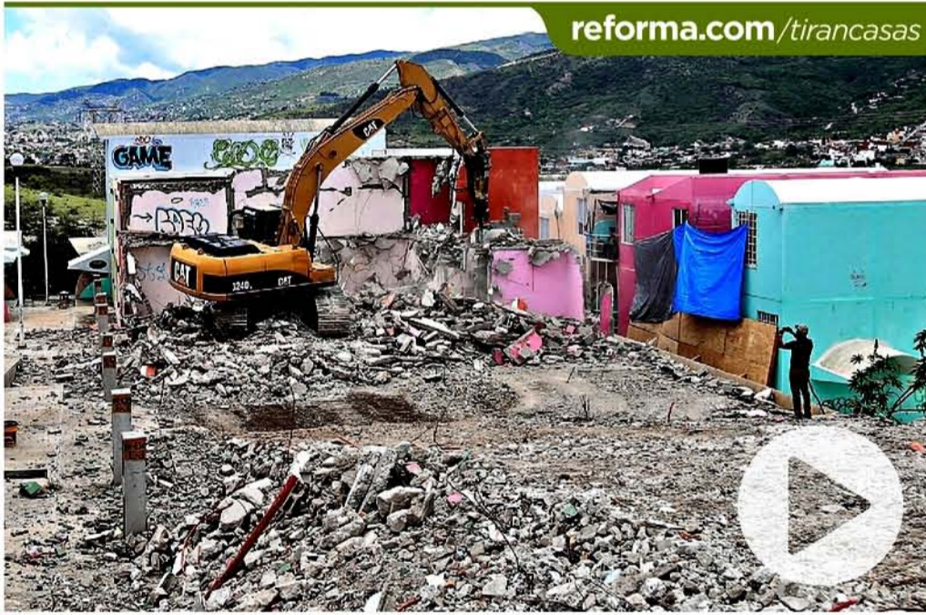
Las viviendas del Nuevo Mirador, a las afueras de Chilpancingo, comenzaron a ser demolidas esta semana, dos años después de que fueran declaradas inhabitables por Protección Civil.
