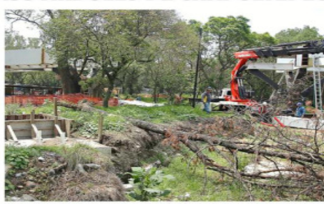
Los trabajos para construir la Calzada Chivatito ya iniciaron.
