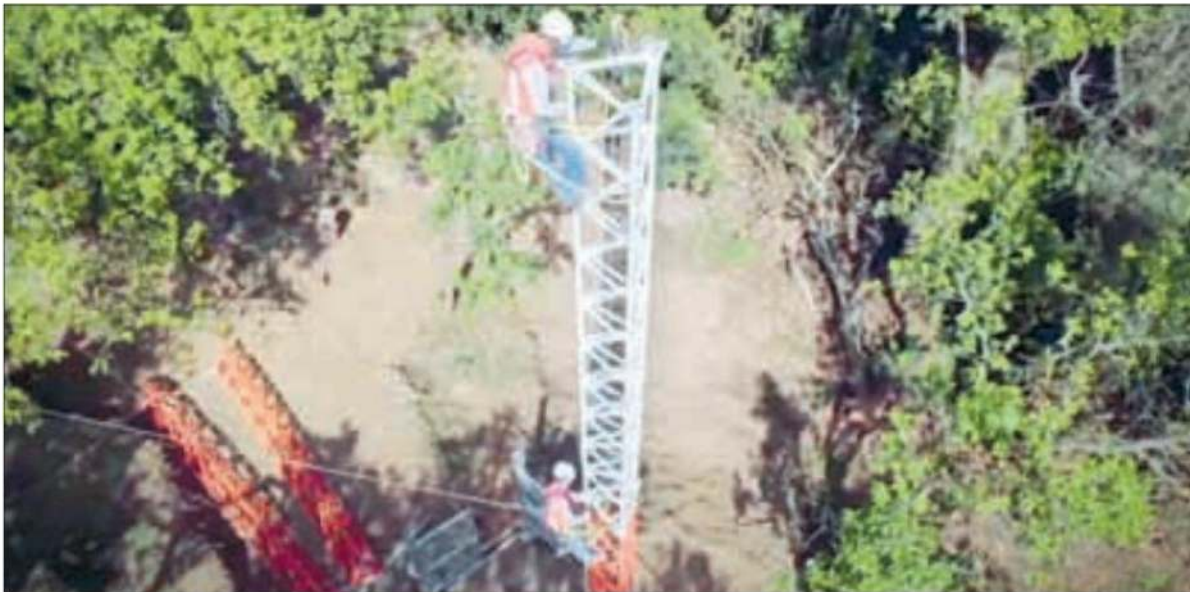
▲ Instalación de torres de la Comisión Federal de Electricidad en Temascaltepec, estado de México, para el proyecto de Internet para Todos. Foto CFE
