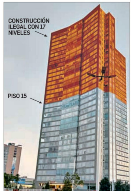
▲ La Torre A Olivo, del complejo High Park Sur, en Periférico Sur 5550, alcaldía Coyoacán, originalmente sería de 15 pisos. Sin embargo, la construcción
