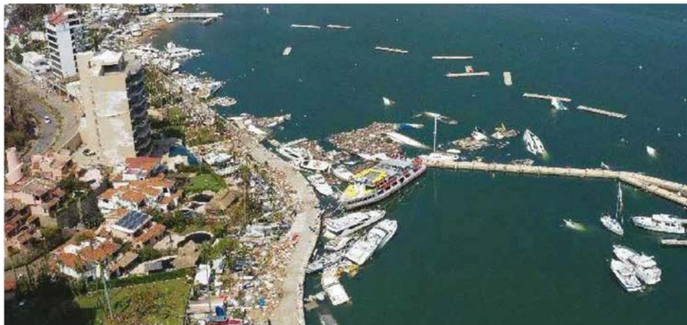
Parte de los daños estructurales en la Bahía de Acapulco. (Foto: Cuartoscuro)
