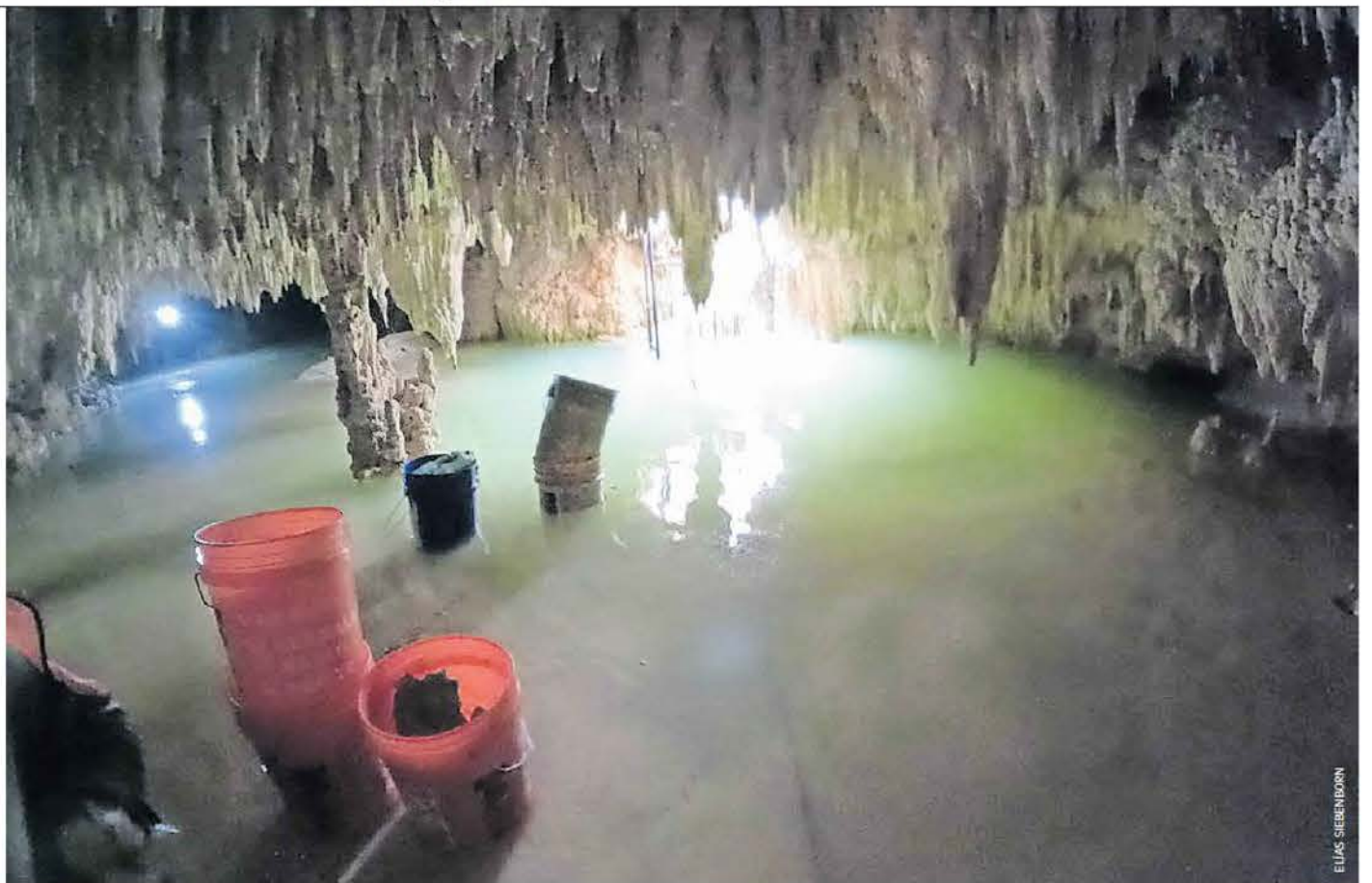
En el informe se detalla que al colocar los pilotes hubo afectaciones en las cavernas sobre las que corre el Tramo 5 Sur, como la caída de cemento en el agua.
