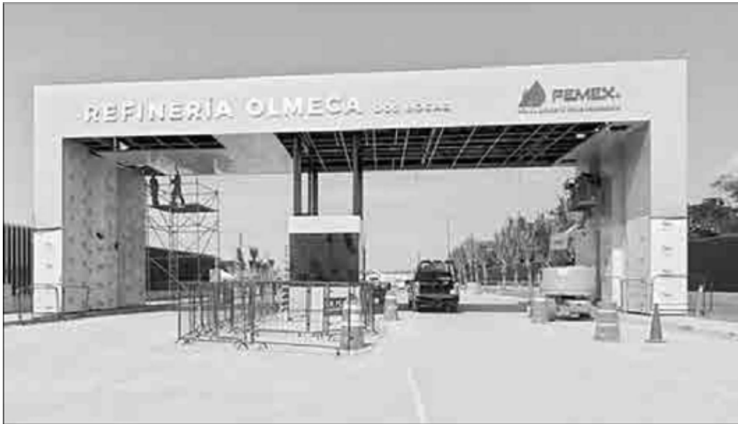
La refinería Olmeca, en Dos Bocas, Tabasco, la primera en construirse en 43 años. Foto La Jornada
