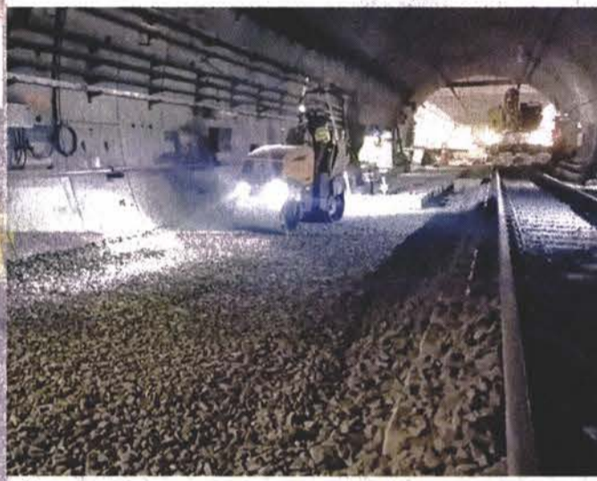
Últimos trabajos en la parte subterránea de la Línea 12 del Metro antes de iniciar los 15 días de pruebas.
