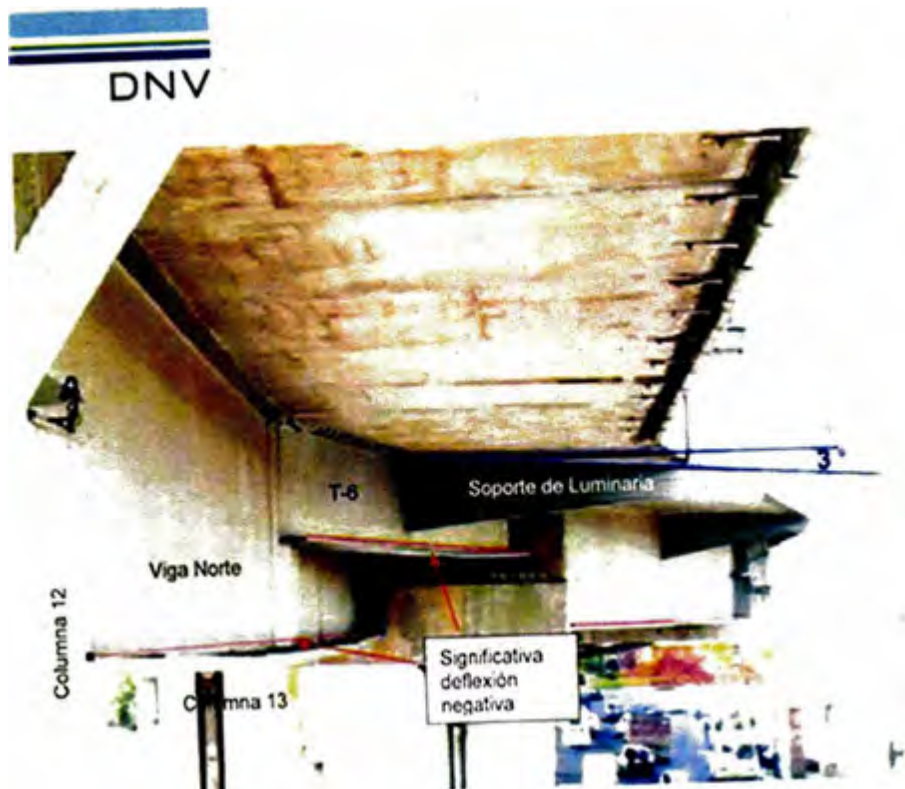
Figura 47. Fotograma adquirido de una secuencia en video de una inspección por drones realizada en diciembre de 2019 que muestra una importante deflexión negativa de la Viga Norte y de la Viga T-6 entre las Columnas 12 y 13.
