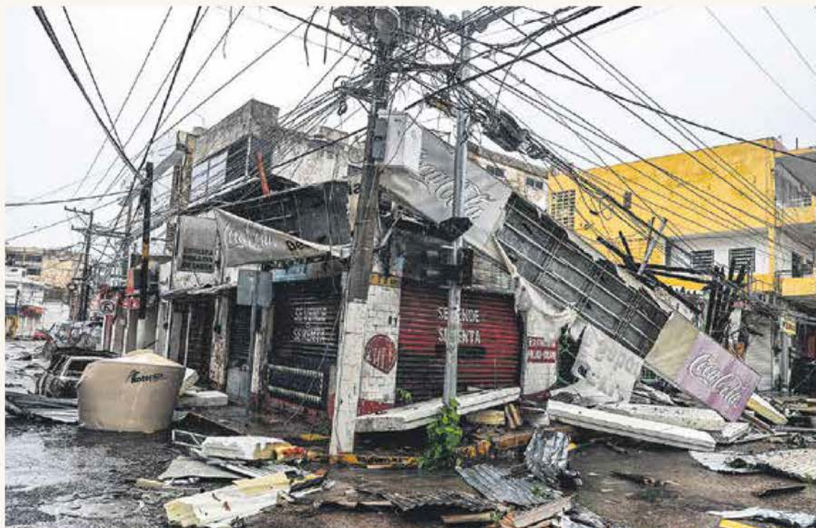
La peor parte. Todas las afectaciones están en Acapulco, donde se registraron las muertes y los daños materiales.
