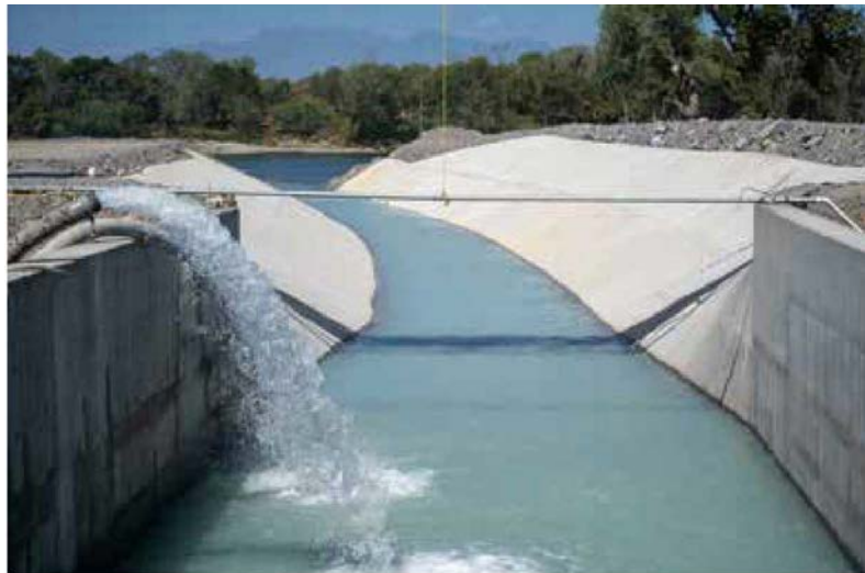
Se espera que la recién inaugurada Presa Libertad logre una óptima captación de agua durante los próximos periodos de lluvia.
