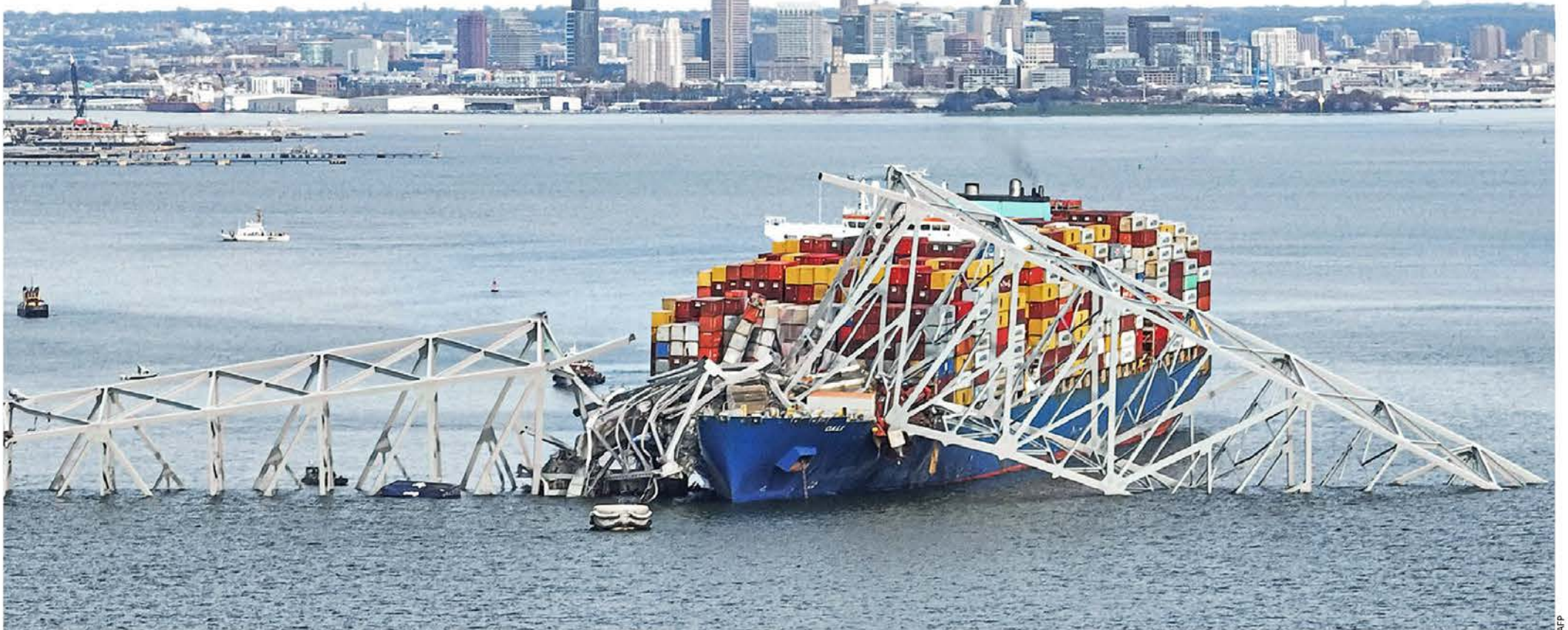
COLAPSO EN BALTIMORE. Un buque chocó contra un puente en EU, tras una falla eléctrica. La Guardia Costera suspendió el rescate de 6 desaparecidos, al menos uno mexicano MUNDO P. 16
