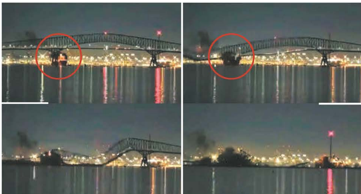
El emblemático puente de Baltimore, considerado entre los más grandes en la Costa Este de EU, fue destruido por completo en minutos, tras ser embestido uno de sus soportes por el carguero "Dali", en círculo rojo. Hay al menos seis desaparecidos. (Fotos: Captura de pantalla de video de seguridad) ▶ 13
