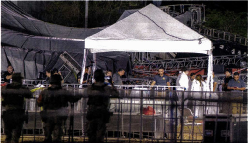
EL ESCENARIO que se desplomó durante el evento de Movimiento Ciudadano, en San Pedro Garza García.
