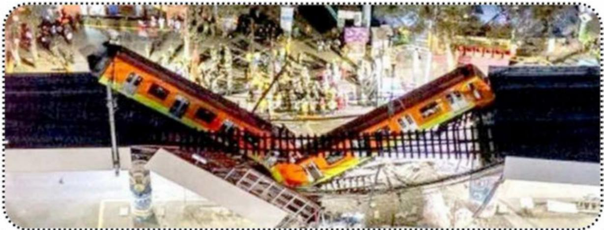
**Tramo colapsado estructura de la Línea 12 del Metro entre estaciones Olivos y Tezonco**
