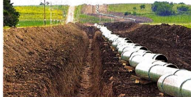
El proyecto de 420 km está frenado en un tramo de 10 km.
