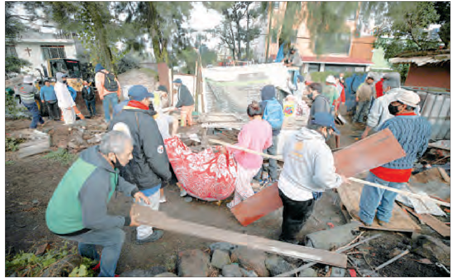
▲ Unas 100 personas fueron expulsadas de un terreno de 5 mil 200 metros cuadrados que pertenece a la reserva del Cerro de la Estrella. Las autoridades usaron maquinaria pesada para derribar las viviendas que se edificaron de manera ilegal hace casi 40 años. Los afectados advirtieron que pondrán una queja ante la Comisión de Derechos Humanos capitalina. Foto Alfredo Domínguez. JOSEFINA QUINTERO / P 33
