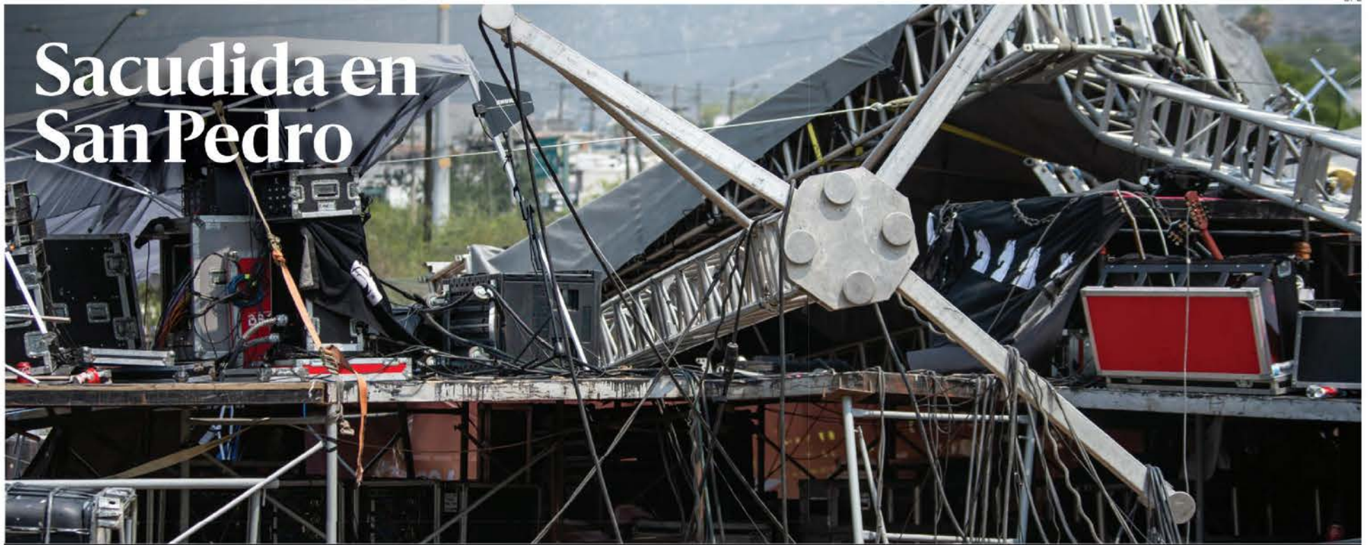
Las estructuras metálicas que soportaban el templete del mitin de Movimiento Ciudadano fueron colapsadas por las ráfagas de viento.
