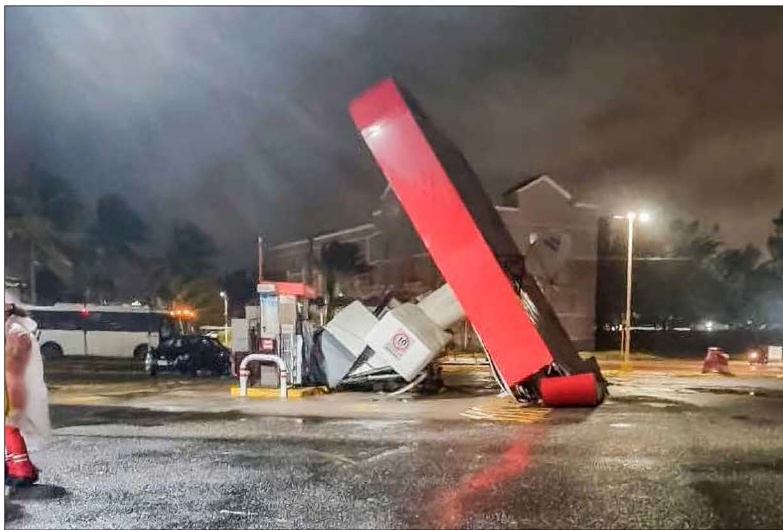
▲ Con vientos de 97 kilómetros por hora, el meteoro afectó el sur del estado, así como el puerto veracruzano. Hubo reportes de caída de árboles, inundaciones y cortes en el servicio de electricidad. En Tierra
