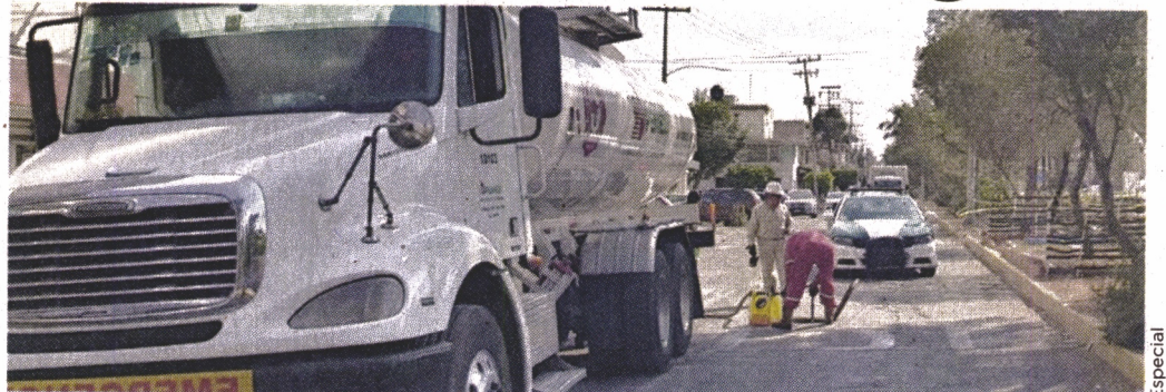
■ Cuadrillas de Pemex y de SGIRPC limpiaron colectores de desagüe en la zona.
