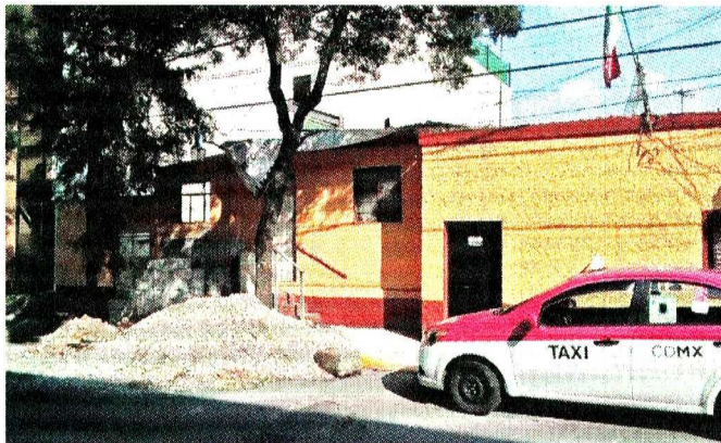
■ Los vecinos aseguraron que los trabajos de reconstrucción en casas de la Colonia Acueducto avanzan con rapidez.
