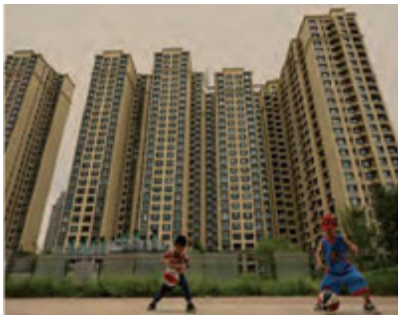
Los problemas de la vivienda en China pueden afectar los activos de diversos fondos. FOTO: REUTERS
