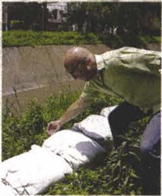
En Naucalpan pusieron sacos para prevenir el desbordamiento de un canal.
