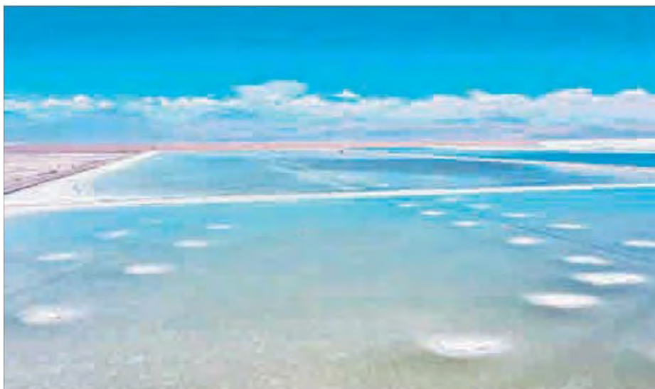
Estanques de salmuera y áreas de procesamiento del yacimiento de litio de la firma chilena Sociedad Química Minera, en el desierto de Atacama, en septiembre pasado. Foto Afp
