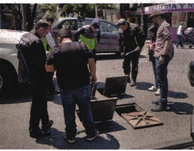
Además del análisis de la calidad de agua, se realiza desazolve del drenaje.
