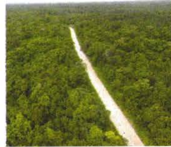
La construcción de la obra contará con más de 143 mmdp.
