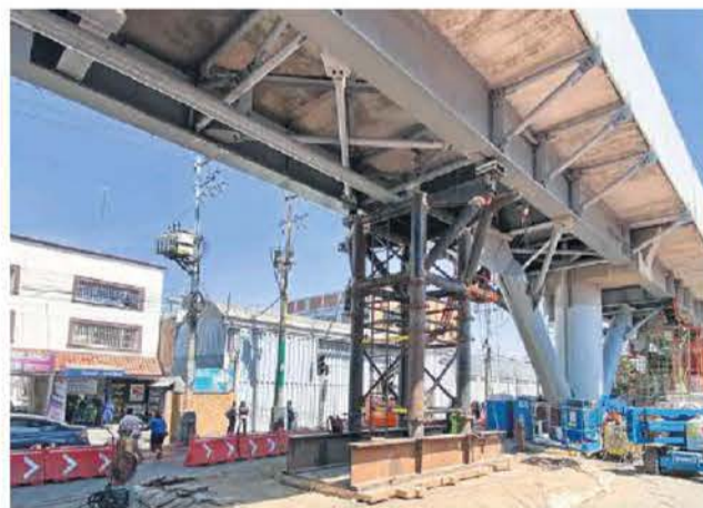
Las 13 mil toneladas de acero se han utilizado para rehabilitar el tramo elevado de la Línea Dorada que colapsó en mayo de 2021.
