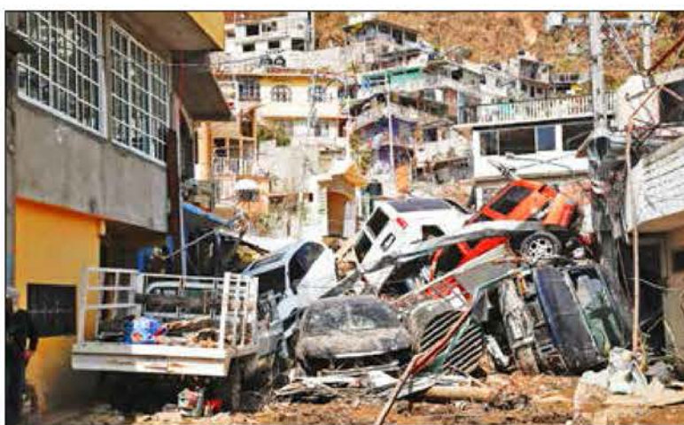
▲ Enormes destrozos causó Otis en las partes elevadas de la colonia Revolución del Sur, en el puerto de Acapulco. Foto Víctor Camacho
