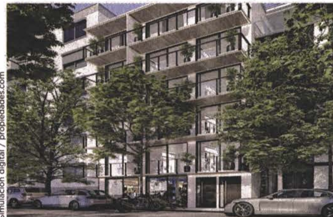
Vecinos denunciaron que fueron construidos pisos extra en Oaxaca 33 sin los permisos legales.
