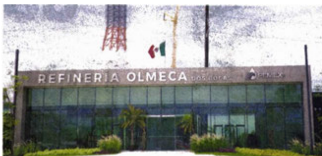
Refinería Olmeca, en Dos Bocas, Tabasco.
