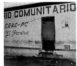
Fachada de local usado como prisión
