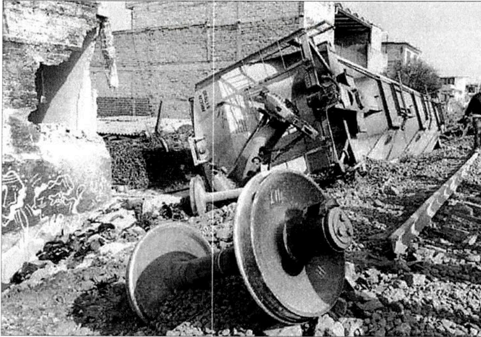
Uno de los dos vagones que se desengancharon de un tren de carga, propiedad de una firma trasnacional, descarriló y afectó varias viviendas en Jardines de Casanueva, en la zona conocida como Cerro Gordo, en Ecatepec. El transporte llevaba toneladas de maíz, las cuales cubrieron parte de las construcciones afectadas. La concesionaria de la ruta ferroviaria y la empresa dijeron que están dispuestas a pagar las indemnizaciones correspondientes. ■ Foto Javier Salinas
