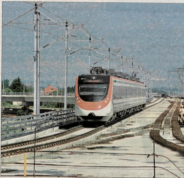
Prueba de uno de los primeros trenes de la obra.
